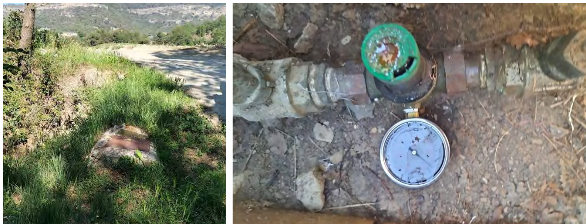
Figura 36. Vàlvula reguladora de pressió Manso Roca d'Oriol
