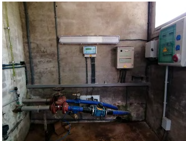
Figura 19. Interior caseta El Clos
