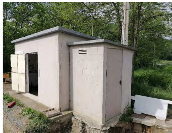
Figura 10. Caseta bombament Can Peirot.
