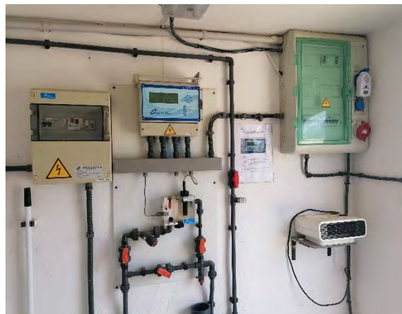
Figura 16. Analitzador/dosificador clor en continu i quadre elèctric.
