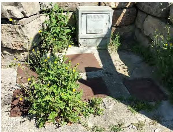
Figura 43. Localització arqueta presa de mostres.
