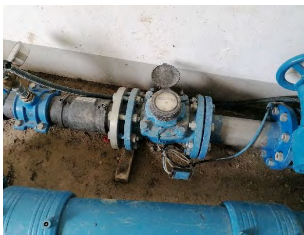
Figura 11. Comptador entrada dipòsit Can Peirot.
