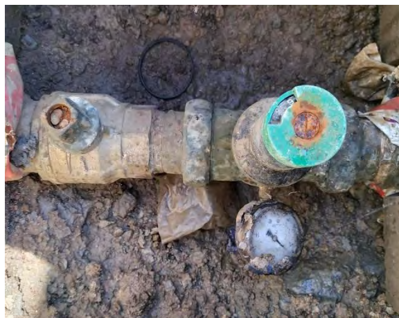
Figura 35. Vàlvula reguladora de pressió Can Pons..
