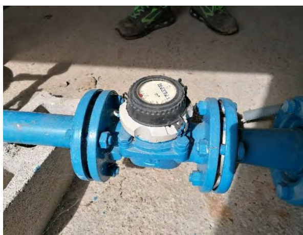
Figura 13. Comptador sortida bombament Can Peirot.
